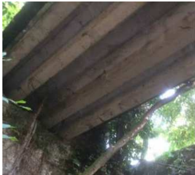
Vista dal basso della passerella
