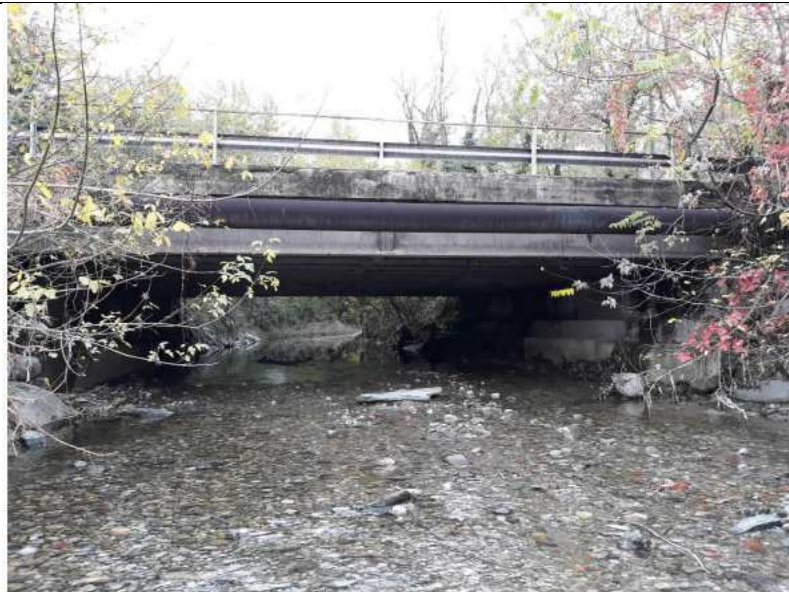
Vista laterale del ponte
