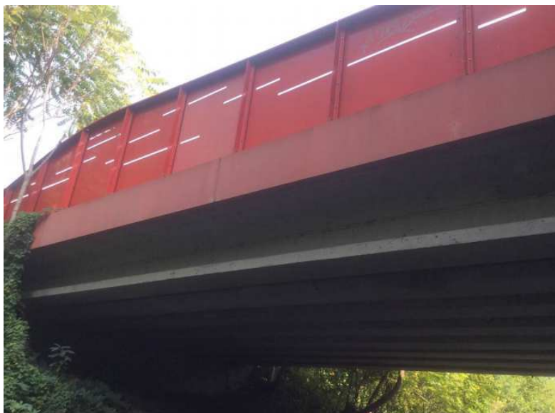
Vista laterale e particolare parapetti
