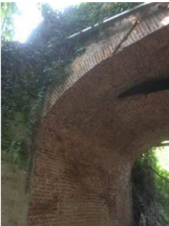
Vista dal basso del ponte
