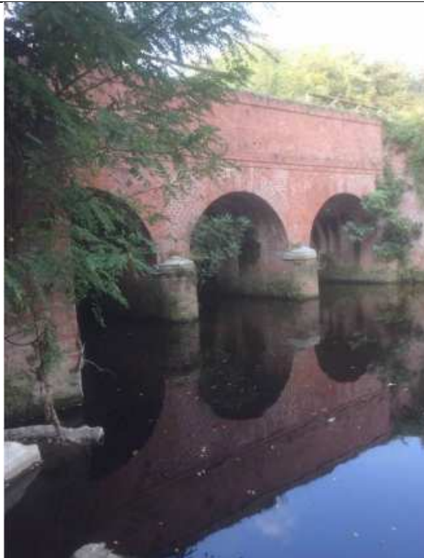
Ponte in muratura a tre arcate – veduta dal fiume Seveso
