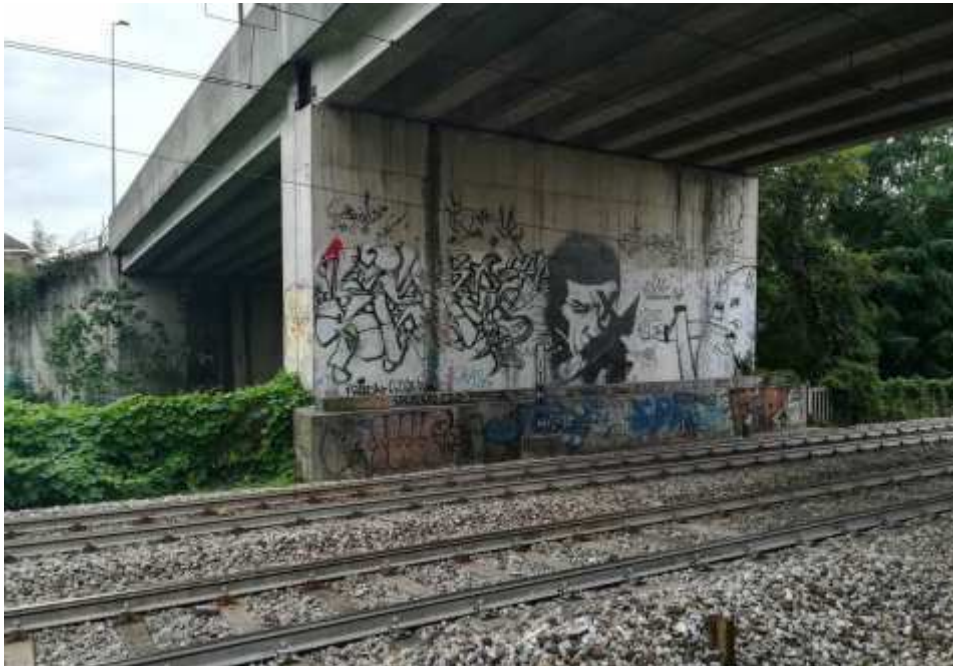
Veduta della Pila centrale
