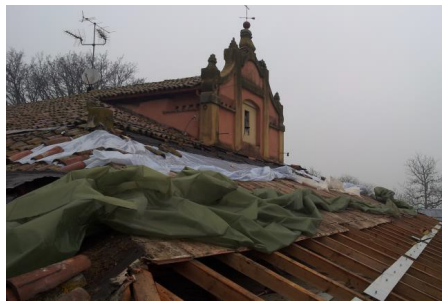
Villa La Paleotta (vincolata ai sensi D.Lgs. 42/2004) di Bentivoglio (Bo): Manutenzione straordinaria per rifacimento tetto e sottotetto
