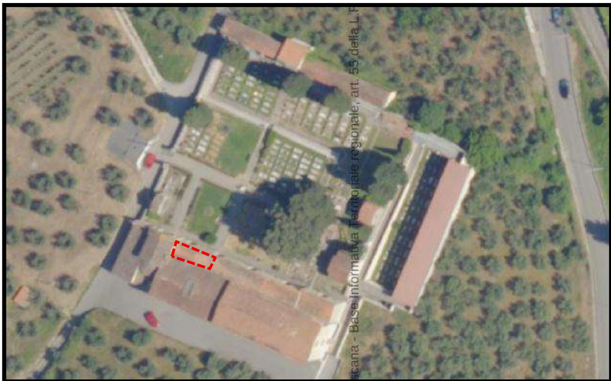
Foto 13, foto aerea con evidenziata la porzione oggetto di intervento
