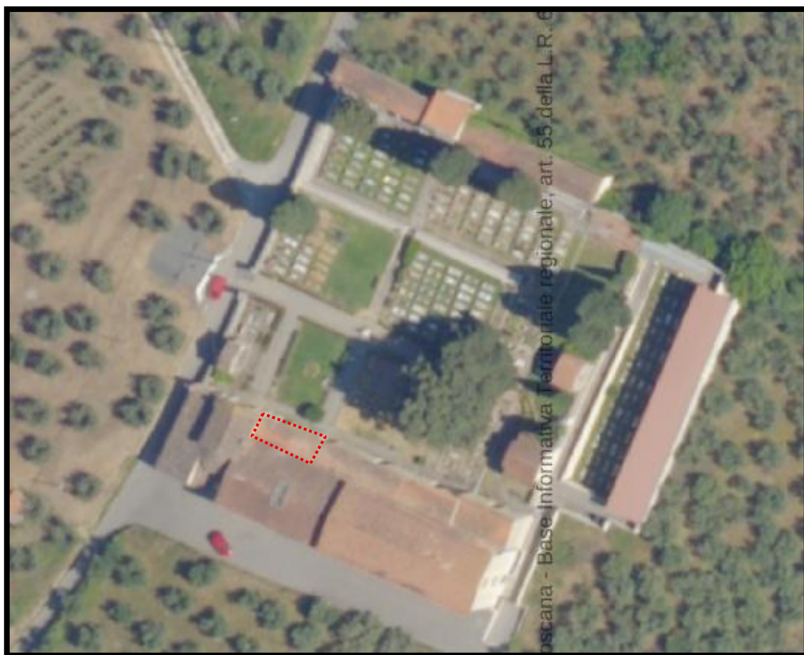
Foto 1 (con evidenziata la porzione di copertura oggetto di intervento)
