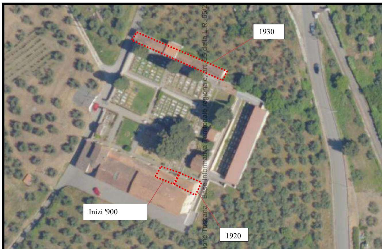
Foto 9, foto aerea attuale con evidenziati gli ampliamenti storici tra il 1900 e il 1940
