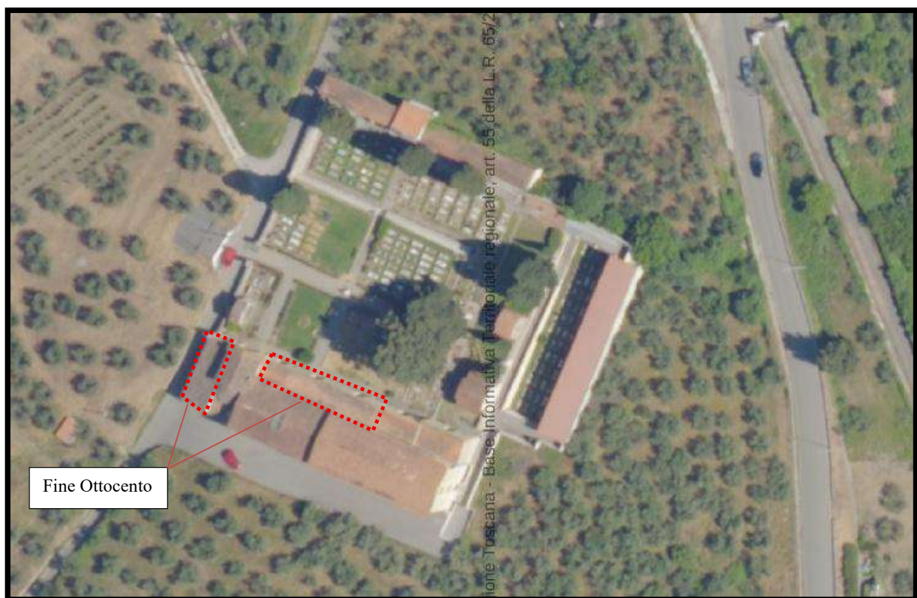
Foto 7, foto aerea attuale con evidenziato i fabbricati in ampliamento di fine Ottocento
