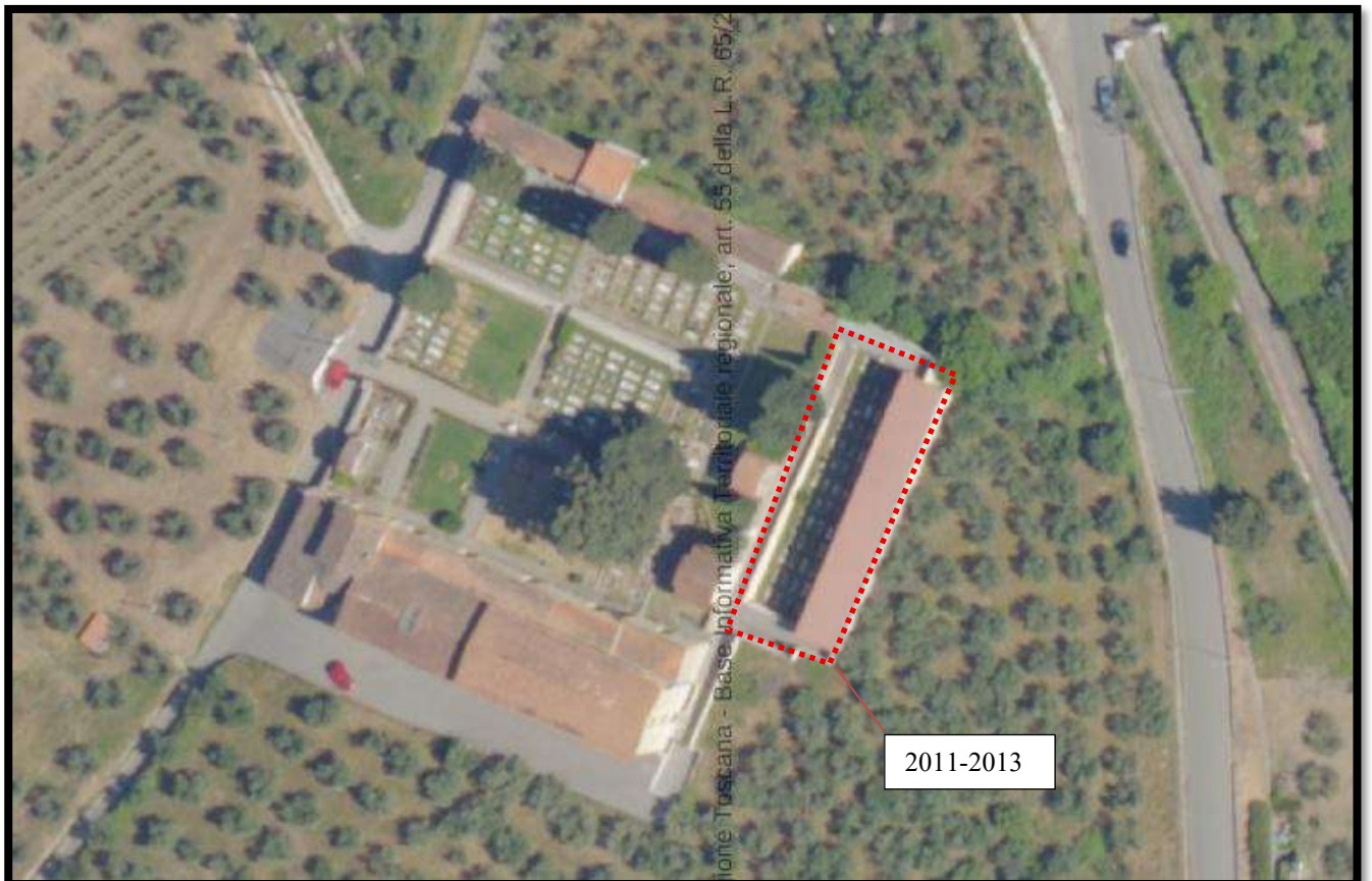
Foto 15, foto aerea attuale con evidenziato ampliamento 2011-2013
