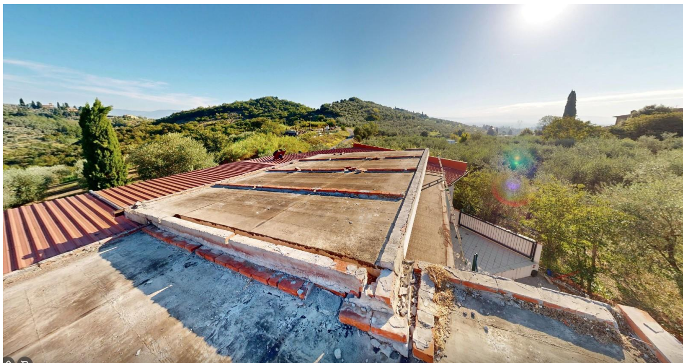
COPERTURA OGGETTO DEI LAVORI
